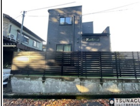
南側外観写真 洗面所・浴室に暖房有り、居室エアコン有り♪キッチンぐるっと回れる家事ラク動線・収納豊富♪
